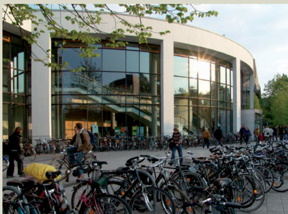
Hörsaalzentrum der Uni
